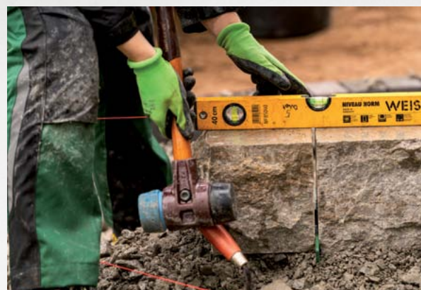
Auf Übungsbaustellen können gezielt vorhandene Defizite bearbeitet und Prüfungssituationen nachgestellt werden.
