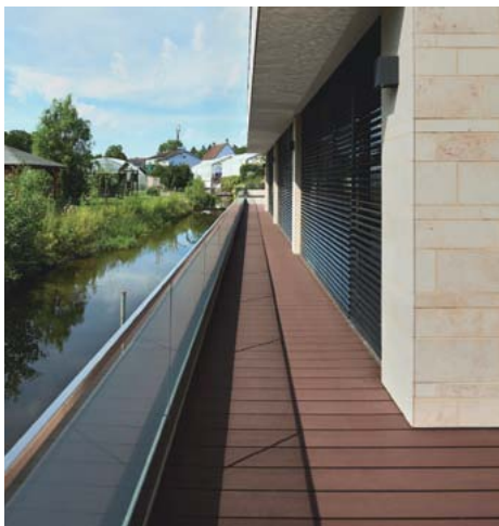
Durch den Verzicht auf Rillen spart „Die Smarte“ an Höhe. Mit ihren 19 Millimetern effektiver Stärke ist sie die bislang dünnste Diele im NATURinFORM-Sortiment. Und trotz ihrer massiven Form erstaunlich tragfähig: Einem Eigengewicht von 2,7 Kilogramm pro laufendem Meter steht eine Belastbarkeit von 400 Kilogramm pro Quadratdezimeter gegenüber.
