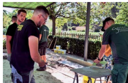
Die Firma SAKRET führte auf der Lehrbaustelle an die „Gebundene Bauweise“ heran. Foto: VGL/Maria Wokurka
